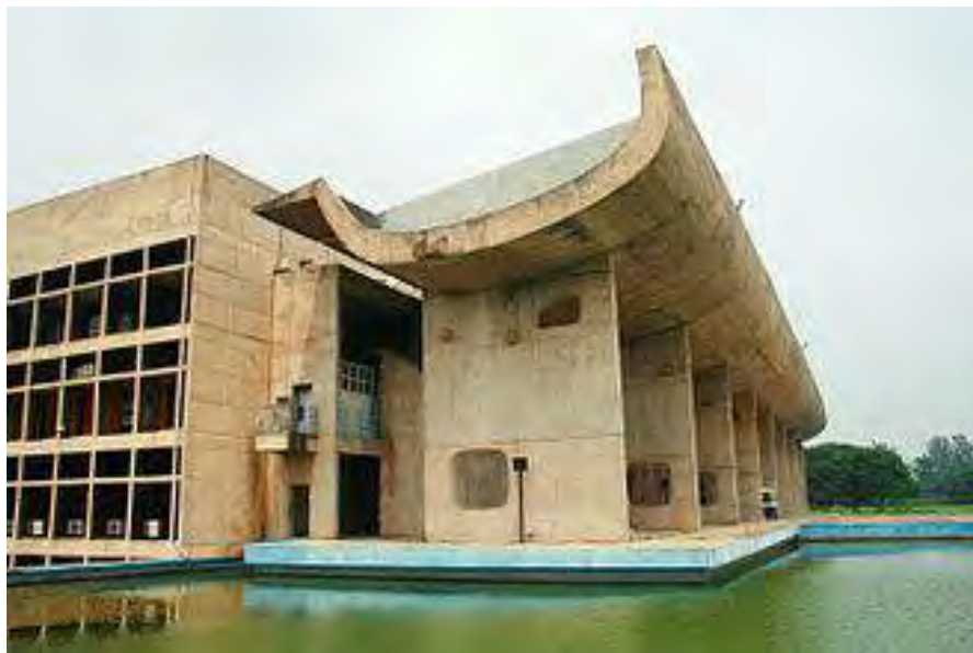
Parlamentsgebäude in Chandigarh (Quelle: wikipedia.de)
