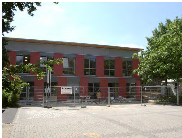
Baustelle pädagogische Einrichtung
